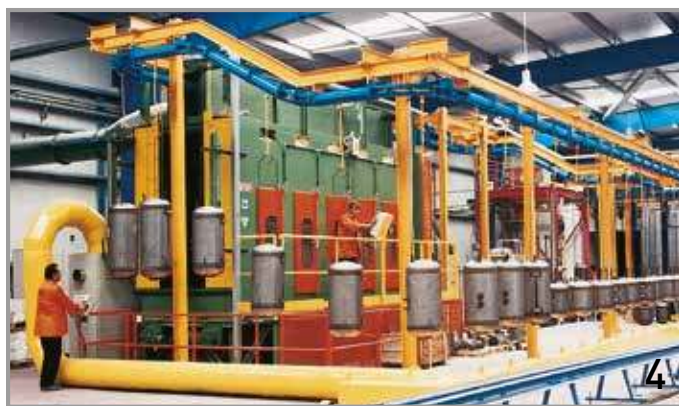
4. Αυτόματο συγκρότημα αμμοβολής / Six - Stage automatic sand-blasting unit
